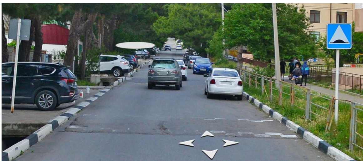
Рисунок 6.12 – Неправильное нанесение и износ горизонтальной дорожной разметки 1.25, наличие просадок и выбоин на Маячной ул.
