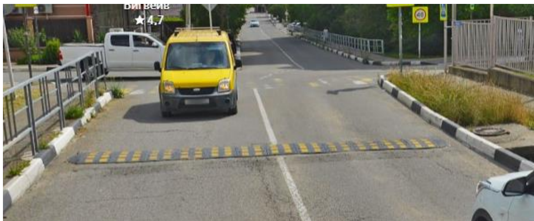
Рисунок 6.11 – Отсутствие горизонтальной дорожной разметки 1.25 на ул. Жуковского.
