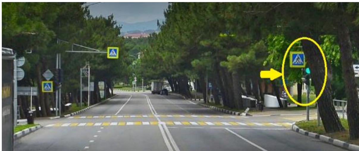
Рисунок 6.1 – Видимость сигналов светофора и дорожных знаков менее 100 м на пересечении Геленджикского пр. и Маячной ул.
