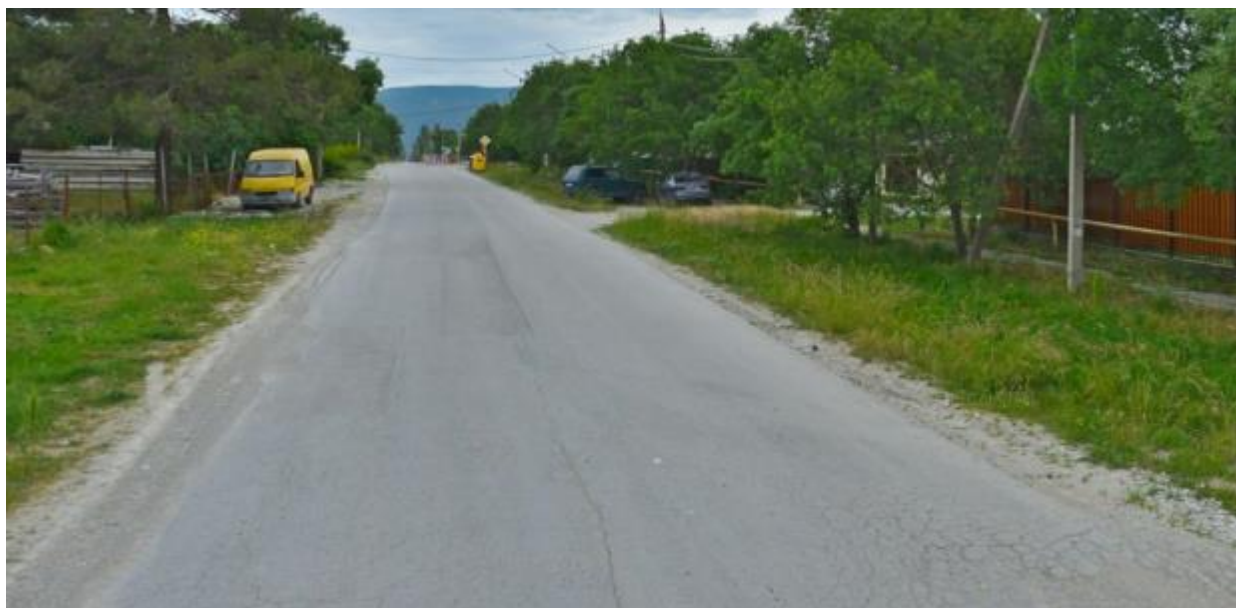
Рисунок 6.2 – Отсутствие горизонтальной дорожной разметки проезжей части по Взлётной улице
