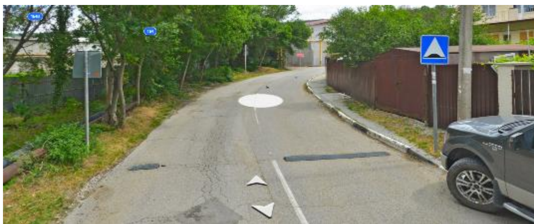
Рисунок 6.10 – Отсутствие отдельных элементов искусственной неровности и горизонтальной дорожной разметки 1.25 на ул. Кончаловского.
