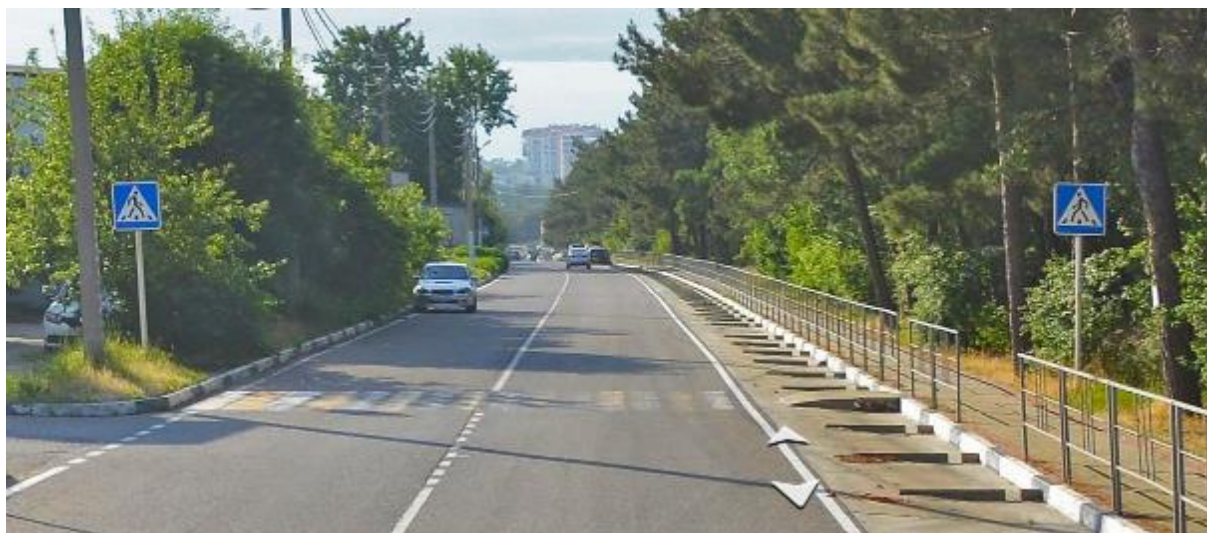
Рисунок 6.7 – Отсутствие желтого-зеленого фона на дорожном знаке 5.19.1(2) на пешеходном переходе по ул. Фадеева.
